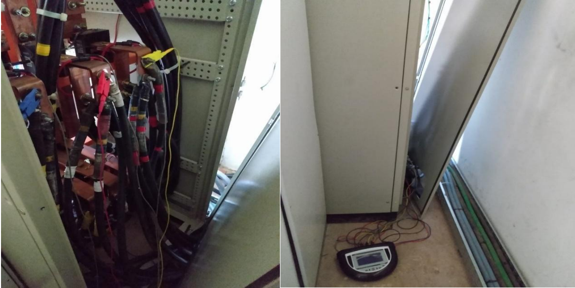
FIGURA 2 - Instalação do medidor na saída do disjuntor geral do QTA 380V
