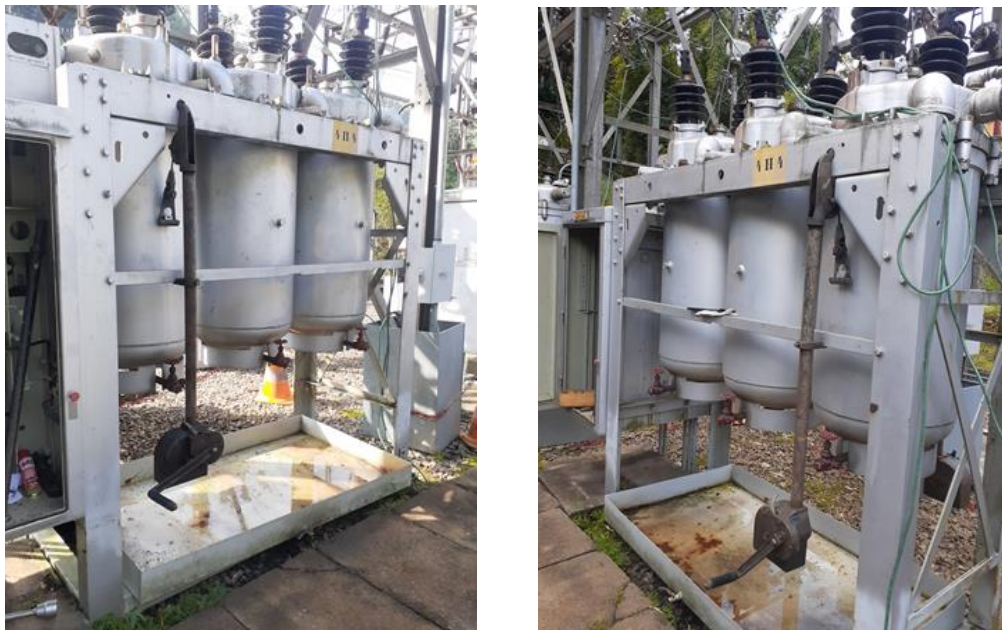
Figura 17 – Instalação de dispositivos para desmontagem das cubas
