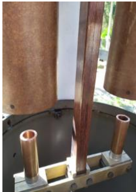
Figura 27 – Reinstalação dos contatos móveis do disjuntor após usinagem
