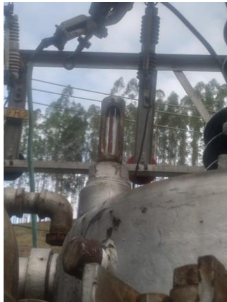
Figura 28 – Indicação de nível de óleo
