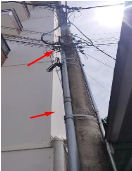
Figura 6 – Realização de um falso ramal.
