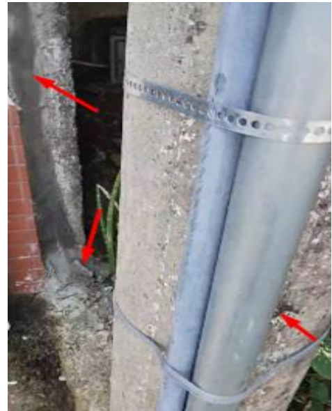
Figura 7 -O local por onde passa o tubo.
