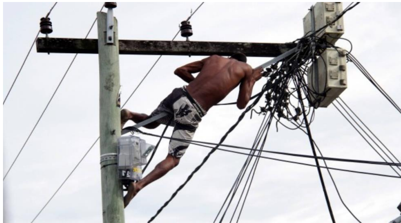
Figura 11 – Flagrante de furto de energia elétrica.
