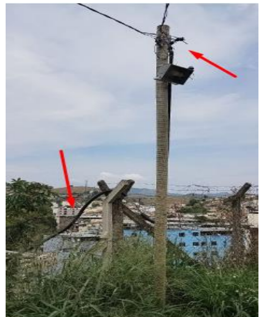
Figura 9 - Chegada do condutor no poste do infrator.
