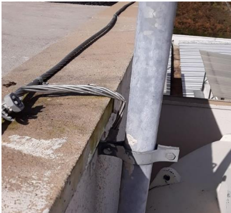
Figura 18 – Interligação do captor Franklin e a malha de captação.
