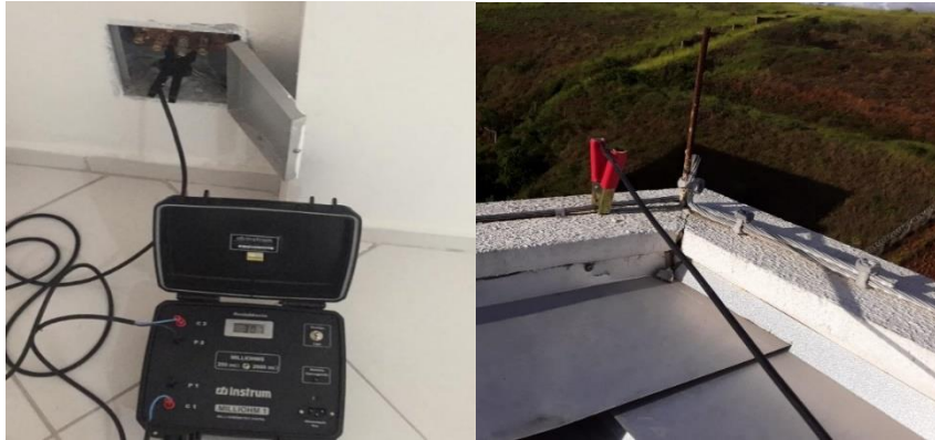
Figura 30 – Como é realizada a conexão do equipamento para medição captação / BEP.
