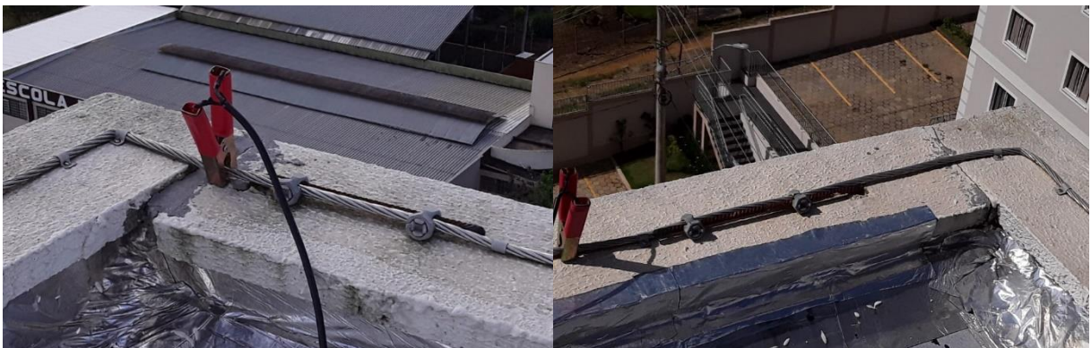
Figura 21 – Minicaptadores amassados em 2 torres diferentes.
