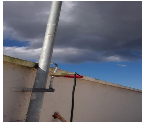
Figura 18 – Interligação do captor Franklin e a malha de captação.
