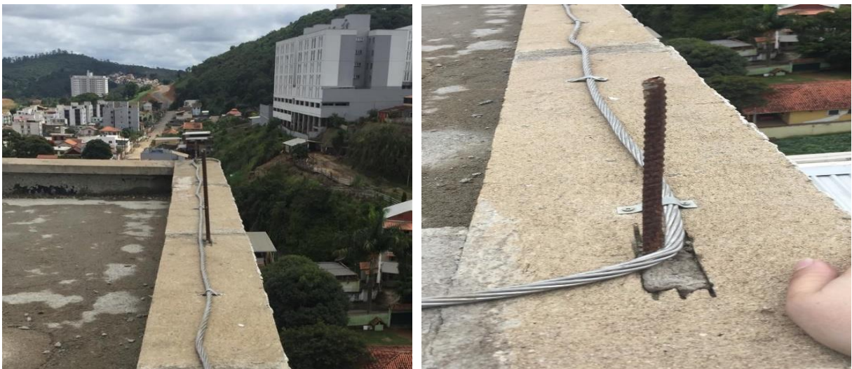
Figura 19 – Malha de captação não conectada nos minicapttores.
