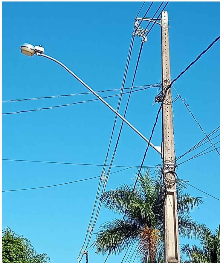
Figura 7 – Rede protegida compacta.
