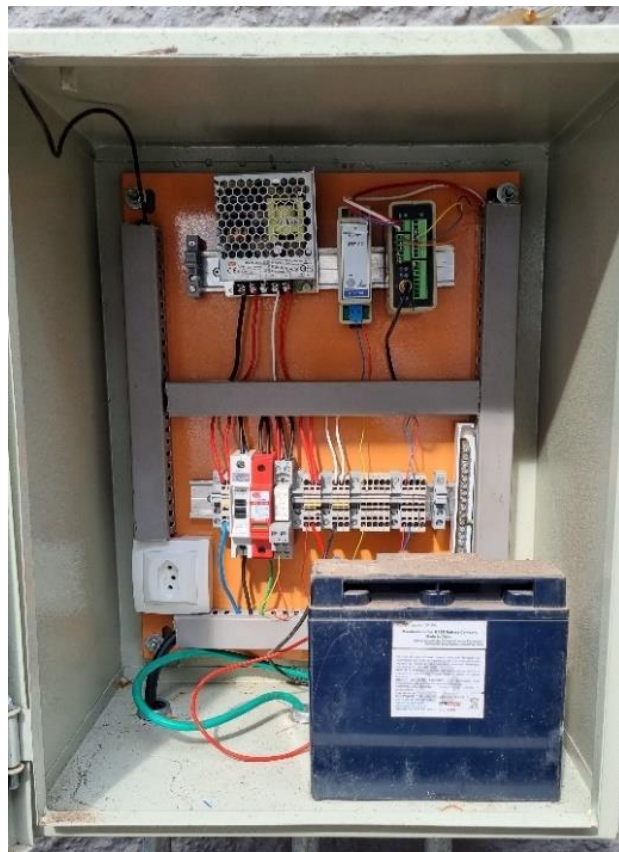
Figura 13 – Painel de Telemetria
