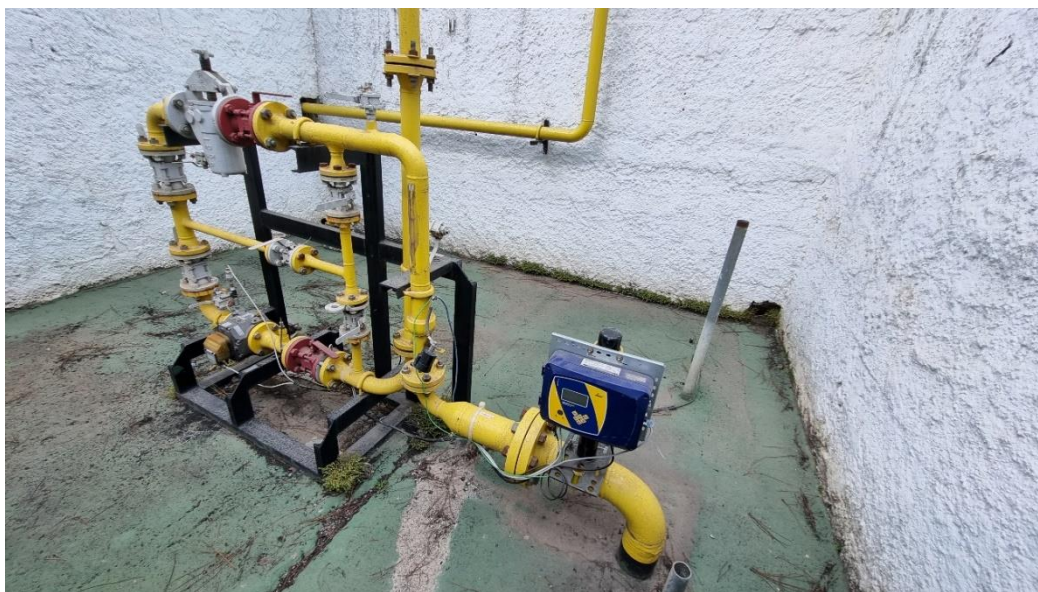
Figura 6 – Conjunto de medição utilizado na distribuição do gás natural
