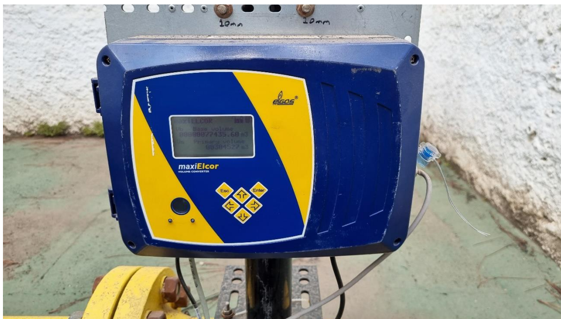
Figura 9 – Conversor de volume tipo PTZ
