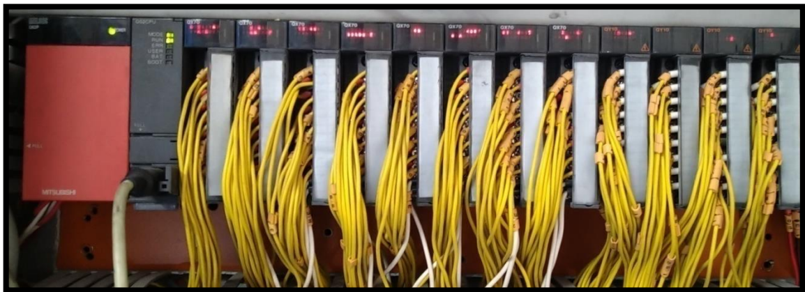
Figura 10 – Instalação e ligação do CLP
