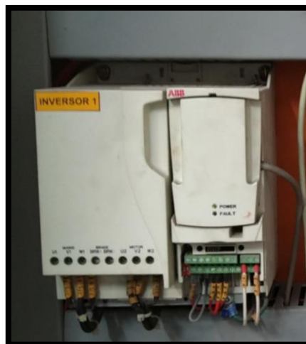
Figura 11 – Fixação e ligação do inversor de frequência
