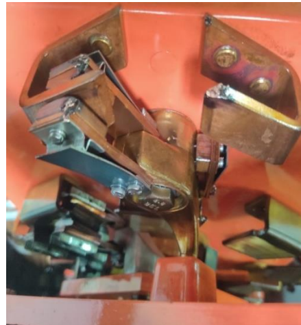
Figura 13 – Chave Reversora de Polaridade.
