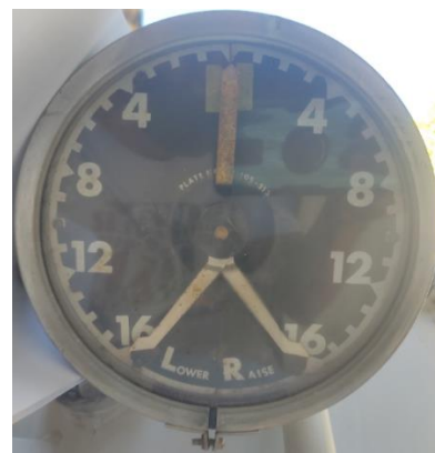
Figura 17 - Indicador de posição da comutadora.
