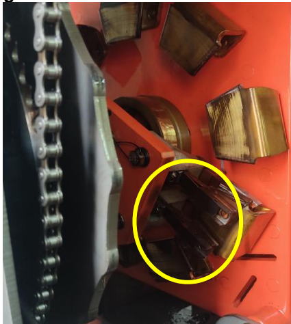
Figura 12 – Contatos Móveis do Reator.
