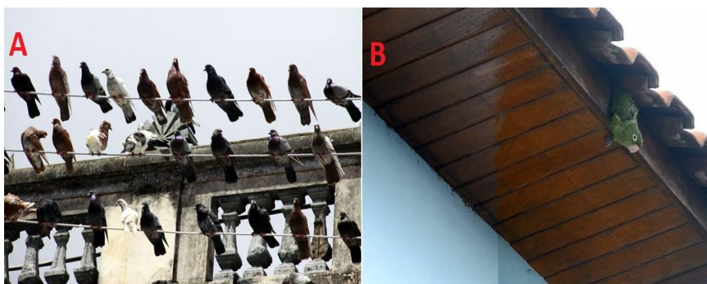
Figura 6: A) Aglomerado de pombos ( Columba livia ) na fiação elétrica dentro da cidade em Natal, RN; B) Maritaca que ficou presa após se abrigar no forro do telhado de uma residência em Itajubá, MG
