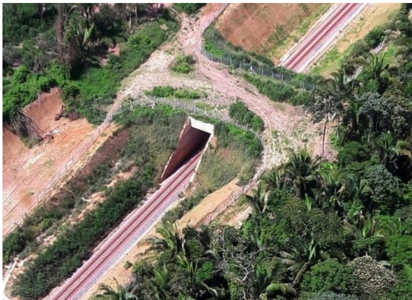
Figura 03 - Primeiro viaduto em uma rede ferroviária, em 2017, construído para a travessia de fauna silvestre ( overpass ), Estrada de Ferro Carajás, estado do Para, Brasil.
