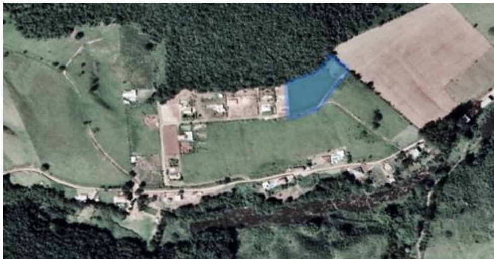
Figura 3: Vista aérea de intervenção do terreno
