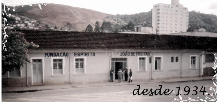
Figura 03: Fachada Principal da Fundação Espírita João de Freitas
