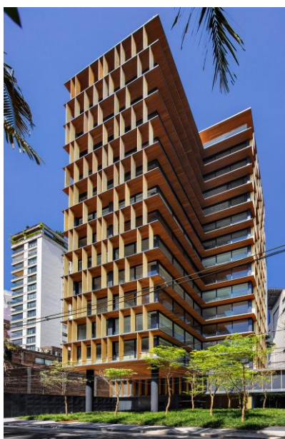
Figura 2: Fachada do edifício Nube
