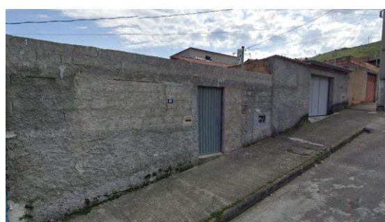
Figura 5: Casas unifamiliares atualmente
