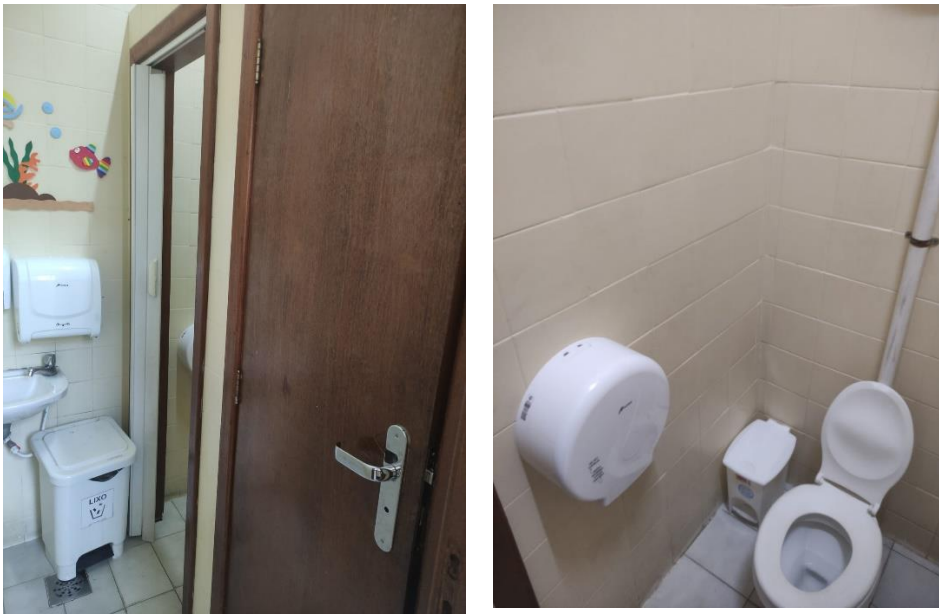
IMAGEM 02: Banheiro masculino atual
