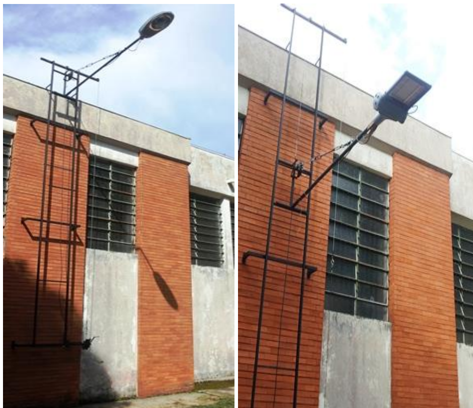
Figura 8: Estrutura de fixação de luminárias.
