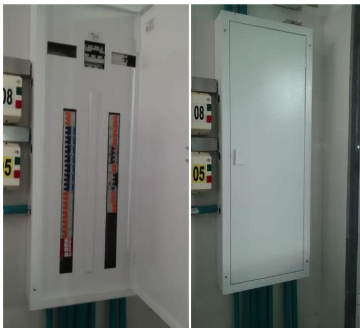
*Quadro novo 70 disjuntores instalado*
